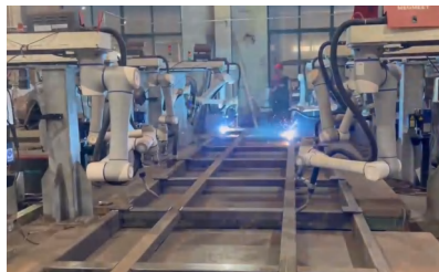
Saldatura telaio in acciaio al carbonio
